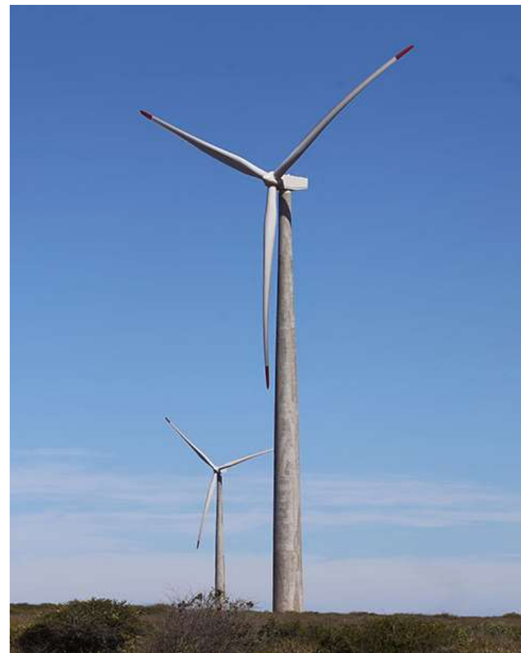
1 Attēlā turbīnas ar dzelzsbetona torni.
